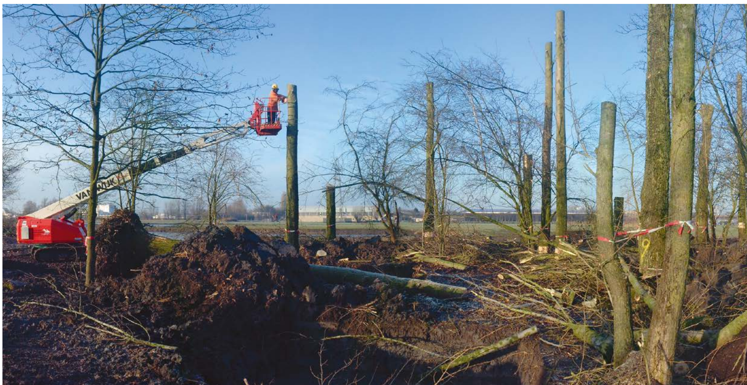
De eerste mijlpaal van Rijnvliet is de aanleg van het vogeleiland afgelopen winter. Hiervoor is een oud populierenbos hergebruikt voor een natuurlijk habitat voor vogels. Het bos viel voor een deel samen met de aanleg van de Buitenvliet. Een deel van de bomen is omver getrokken en de wortelkluif gebruikt als oeverbeschoeiing, andere zijn getopt of er zijn gaten in de stammen aangebracht.
